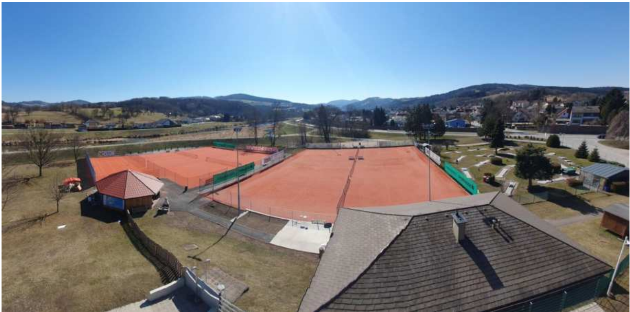
Die seit 2022 erweiterte Tennisanlage mit 5 Allwettertennisplätzen und einem Kidscourt
